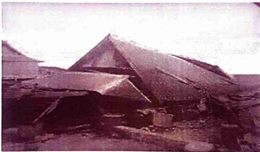
Gambar 2.1 Kondisi Rumah Akibat Gempa Bumi di Kabupaten Kepulauan Selayar
